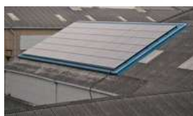
[新社屋屋上に太陽光発電23KW増設][太陽光発電10KWを設置]
