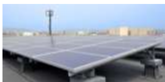
[新社屋屋上に太陽光発電23KW増設][太陽光発電10KWを設置]
