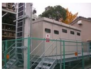
[受変電設備改修] トッパーナー機器へ
