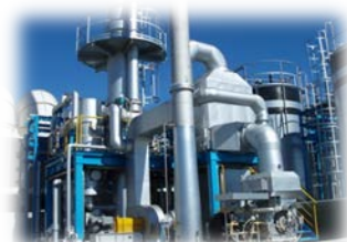
アンモニア処理システム
