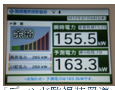
[デマンド監視装置導入]
